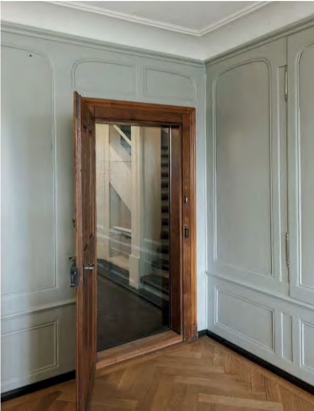
Zimmer 36, 1.Obergeschoss (Aufnahme 2012): Abgelaugte Eichenholztüre mit der neuen Brandschutzverglasung.
