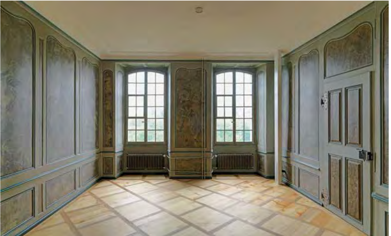
Zimmer 21, Erdgeschoss (Aufnahme 2012): Originaler Bernerparkettboden. Instandgestellte Vertäfelungen. Türfüllungen mit freigelegter und restaurierter Bemalung. Restliche Täferfüllungen mit Neufassung. Die Fenster mit feingliedriger Sprossenteilung (als Mustervorlage angebracht).
