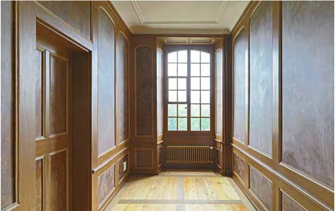
Zimmer 22, Erdgeschoss (Aufnahme 2012): Blick zum Fenster. Die Fenster mit feingliedriger Sprossenteilung (als Mustervorlage angebracht). Restaurierter Bernerparkettboden.
