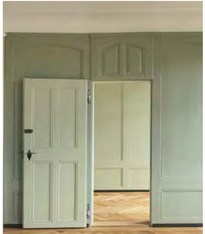
Zimmer 38 und 39, Erdgeschoss (Aufnahme 2012): Instandgestellte Wandvertäfelungen mit Neufassung des raumweise fein differenzierten Originalbefundes.
