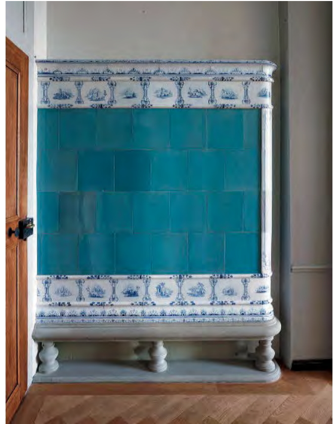
Zimmer 26, 1.Obergeschoss (Aufnahme 2012): Neueingebaute Ofenrückwand mit meergrünen Füllkacheln aus dem Depot der kantonalen Denkmalpflege.
