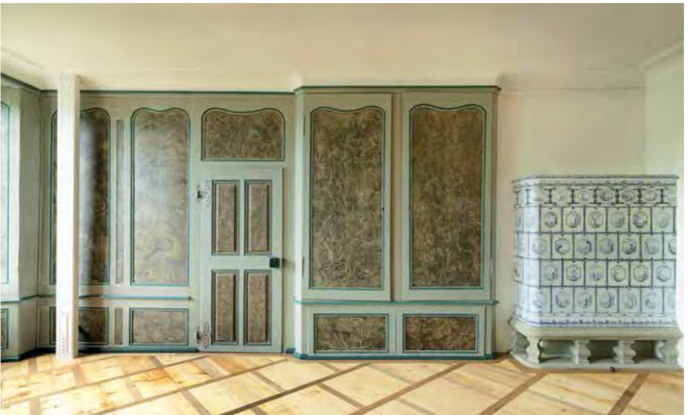
Zimmer 21, Erdgeschoss (Aufnahme 2012): Schrank- und Türfüllungen mit freigelegter und restaurierter Bemalung. Täferfelder links der Türe mit Neufassung. Datierter Kachelofen aus dem Depot der kantonalen Denkmalpflege. Links die neue Elektroerschliessung.
