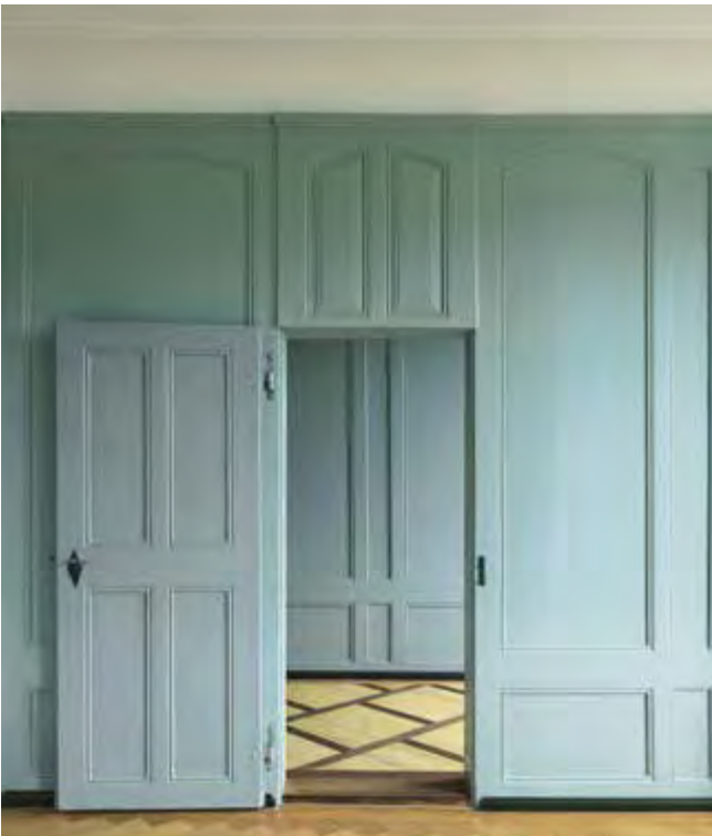
Zimmer 23 und 24, Erdgeschoss (Aufnahme 2012): Instandgestellte Wandvertäfelungen mit Neufassung des raumweise fein differenzierten Originalbefundes.
