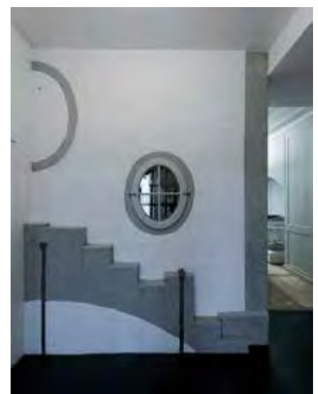
Korridor, Erdgeschoss (Aufnahme 2012): Freigelegte Wandpartie mit Resten eines ehemaligen Treppenaufganges. Die ovalen Fenster boten Durchblick auf die Fricktreppe.
