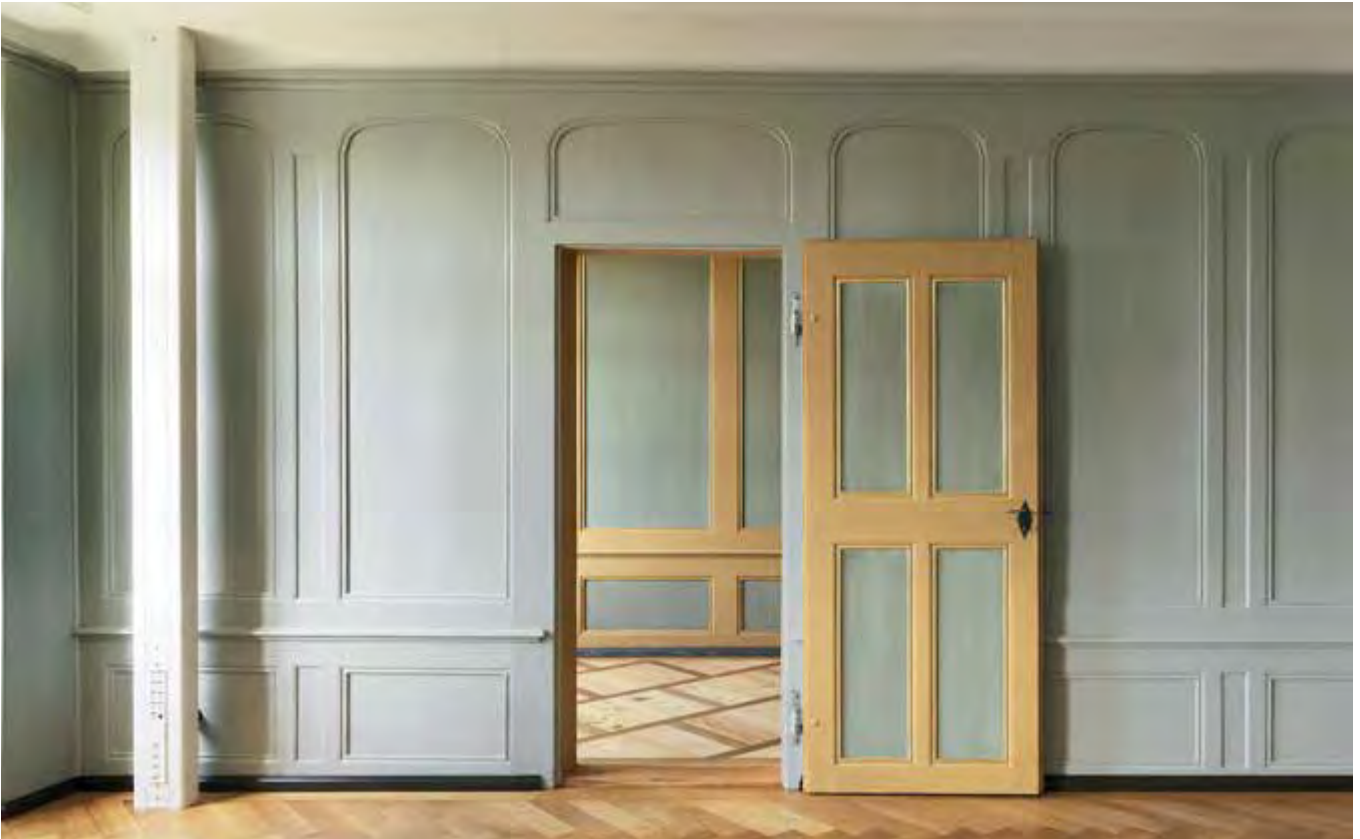
Zimmer 36, 1.Obergeschoss (Aufnahme 2012): Instandgestellte Wandvertäfelungen mit Neufassung des ersten Anstriches. Neuer Elektroinstallationskanal.
