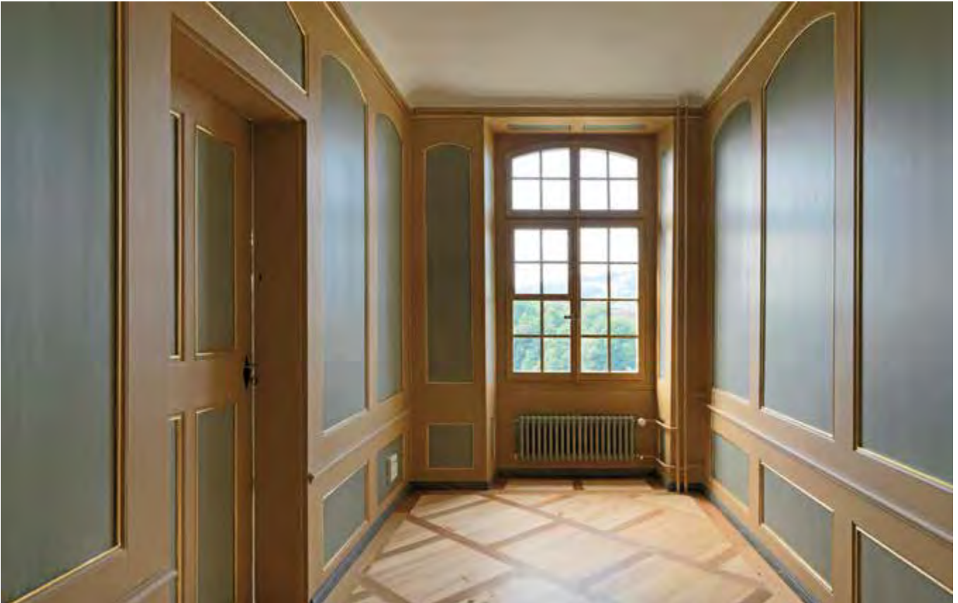
Zimmer 37, 1. Obergeschoss (Aufnahme 2012): Instandgestellte Wandvertäfelungen. Nachbau der zweiten Täferfüllung von links anstelle des nun wieder geschlossenen Brandmauerdurchbruches. Restaurierter Bernerparkettboden. Die Fenster mit feingliedriger Sprossenteilung (als Mustervorlage angebracht).
