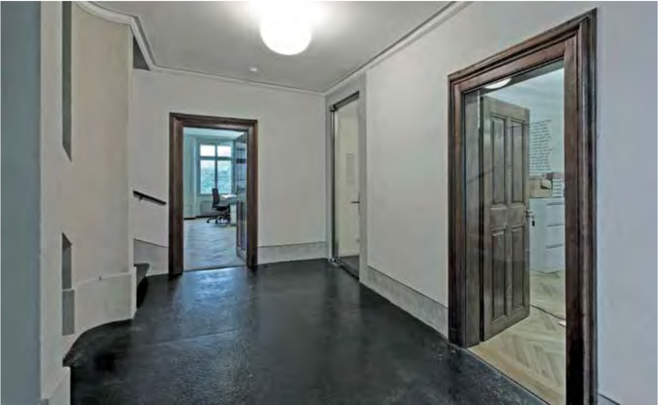
Vestibül, 1.Obergeschoss (Aufnahme 2012): Neue verglaste Brandschutzabschlüsse. Restaurierte Wand- und Deckenoberflächen. Neufassung des Wandsockels.
