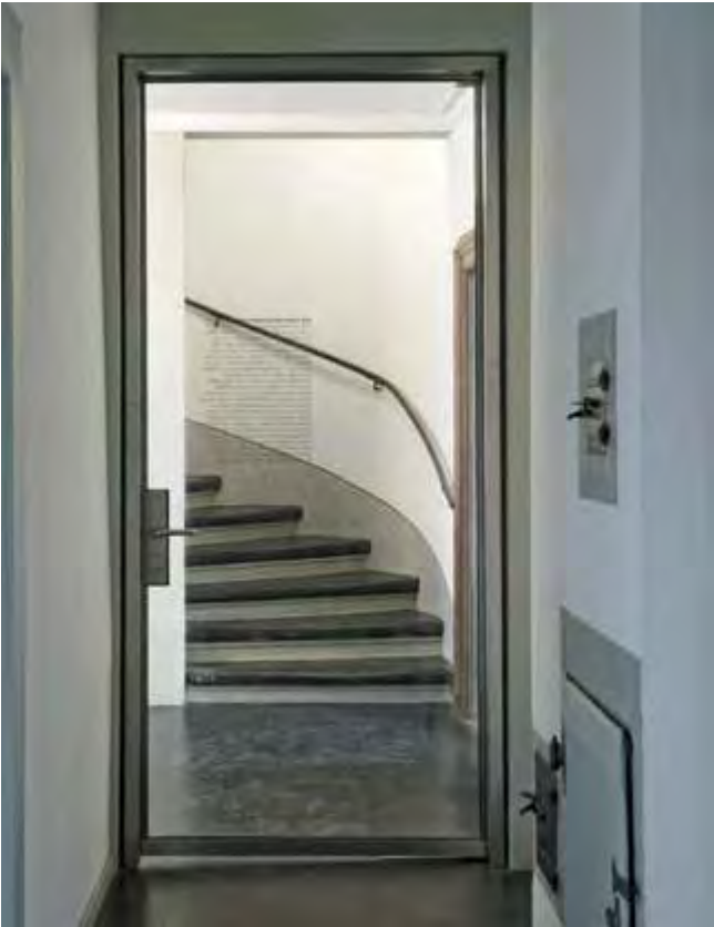
Korridor, 1.Obergeschoss (Aufnahme 2012): Neue Brandschutztüre zum Treppenhaus.
