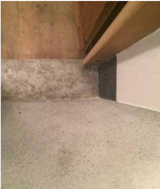
Càsa Cortini: Zusammenspiel von altem Riemenboden, Natursteinschwelle und dem neuen Kalkmörtelboden.
