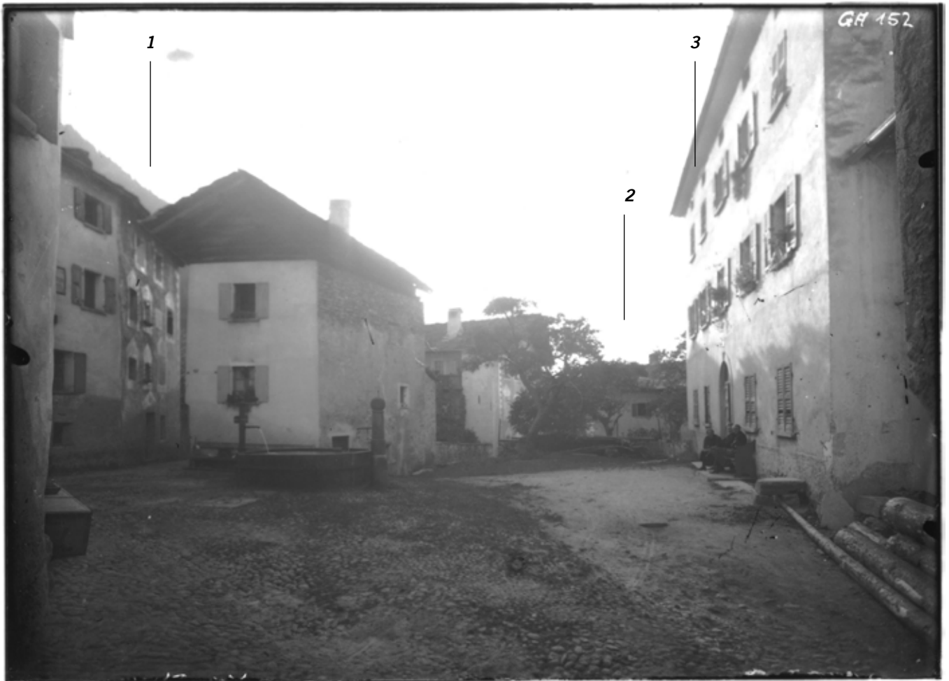
Bondo, Plaza d'Zot: Undatierte Aufnahme von Andrea Garbald (1877-1958). Links hinten an der Flurstrasse steht die Cäsa Cortini, ehemals Stanta (1). In der Bildmitte, hinten, ist das älteste Haus Cortini Nr. 1-28 sichtbar, ein bürgerhausmässiger Bau, erbaut und sgraffitiert 1609, vom Dorfbrand 1621 zerstört und 1624 in der heutigen Form hergestellt (2). Die Familie Cortini hat am rechten Bildrand ebenfalls das jüngste Haus Nr. 1-15 im Jahr 1875 gebaut und platzweiternd zurückversetzt (3).
