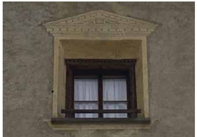
Stampa, Cäsa Granda: Fensterumrandung im Wohngeschoss. Aufnahme 2016.
