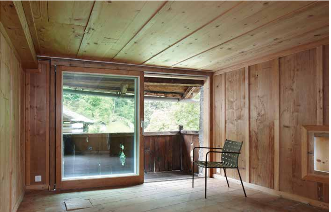
Casa Cortini, 2. Obergeschoss. Neue Fenstertüre zum Balkon über dem Erkeranbau. Aufnahme nach der Renovation.
