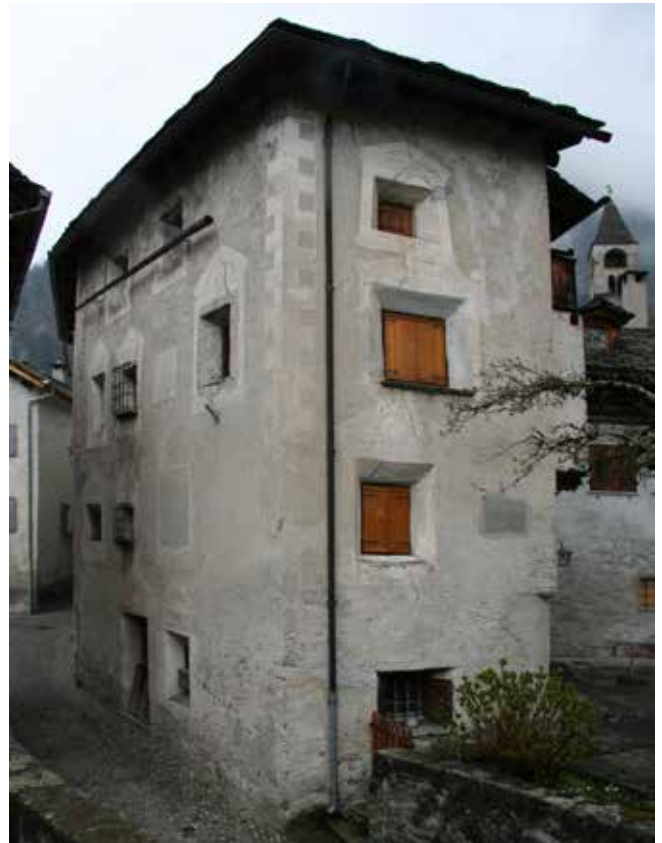
Cäsa Cortini: Doppelhaushälfte Nr. 1-36A. Zustand vor der Sanierung.
