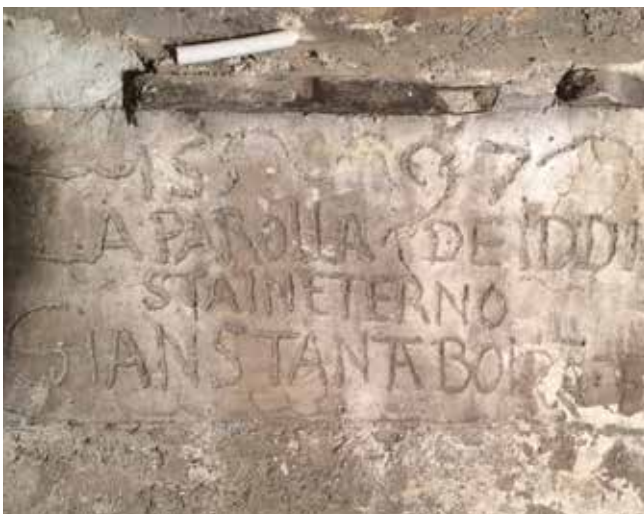
Bondo Haus Nr. 1-36: Bauinschrift auf dem Kamin im Dachboden. Aufnahme 2014.
