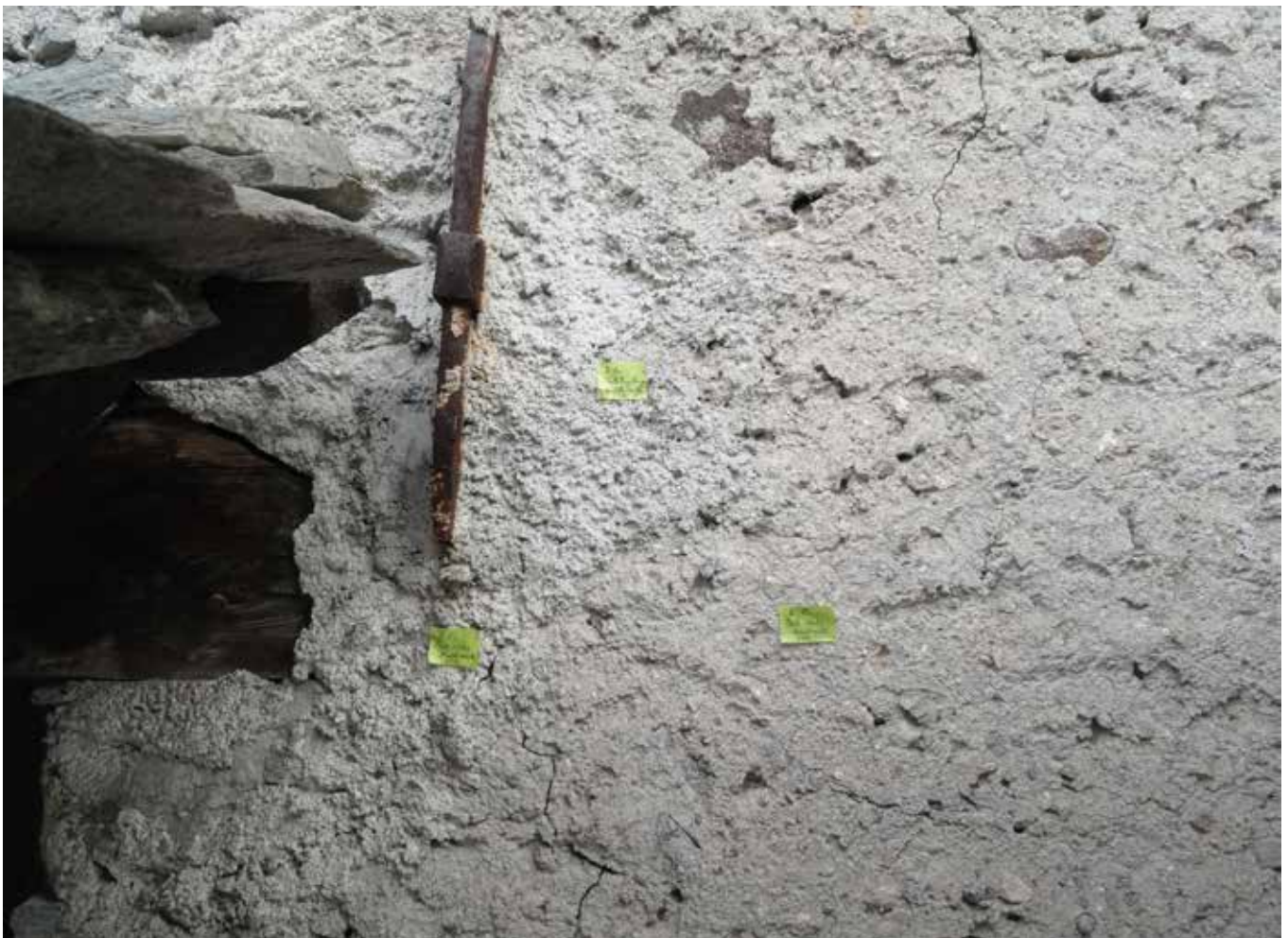
Der Einbau der Zugstangen konnte anhand der Mörtelergänzung auf 1736 datiert werden. Aufnahme während der Restauration.
