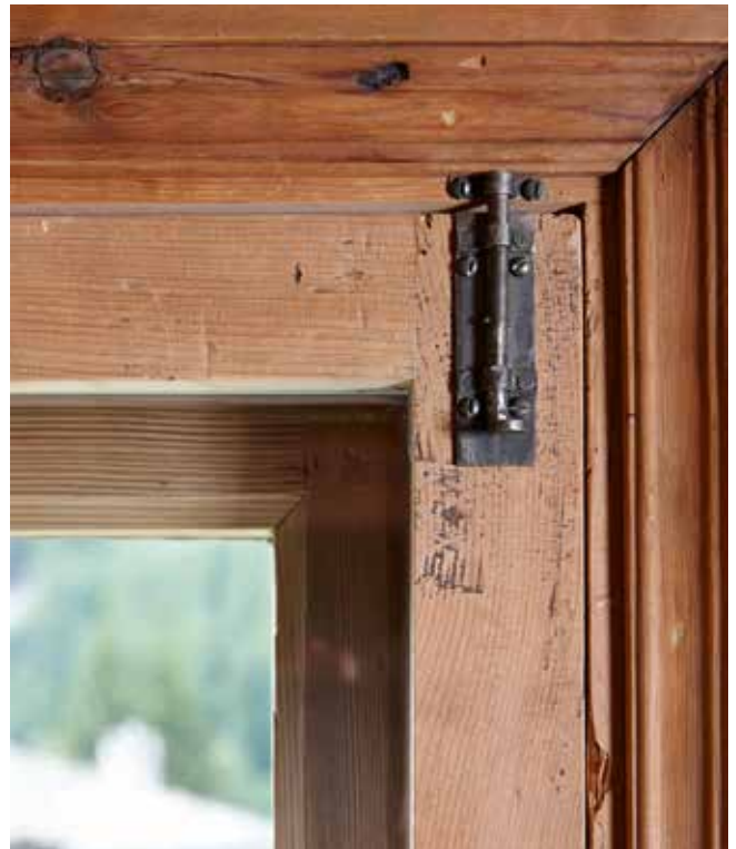
Neues Innenfenster, Detail Verschluss. Aufnahme nach der Renovation.
