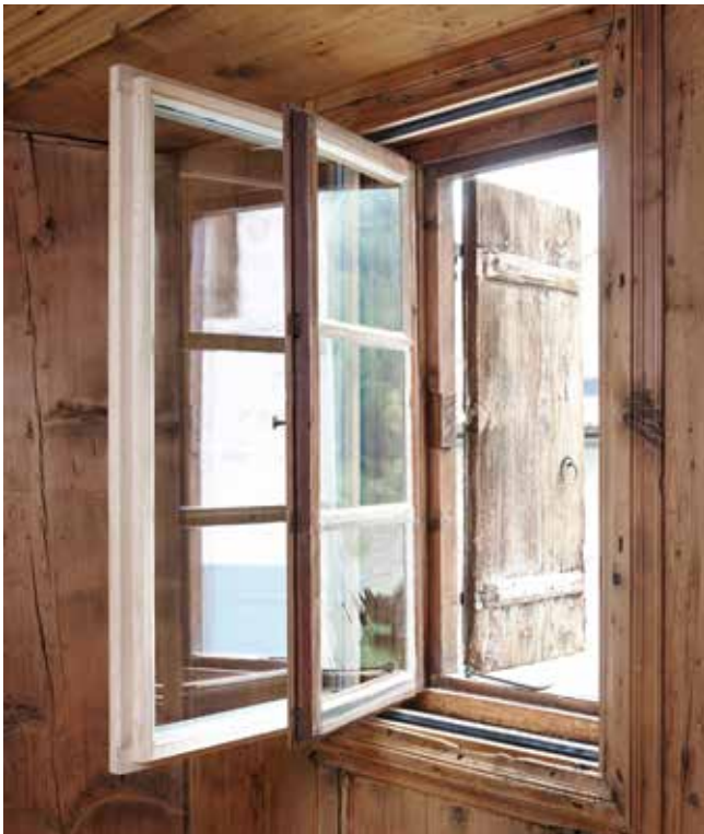
Neues Innenfenster und restauriertes Originalausfenster. Aufnahme nach der Renovation.
