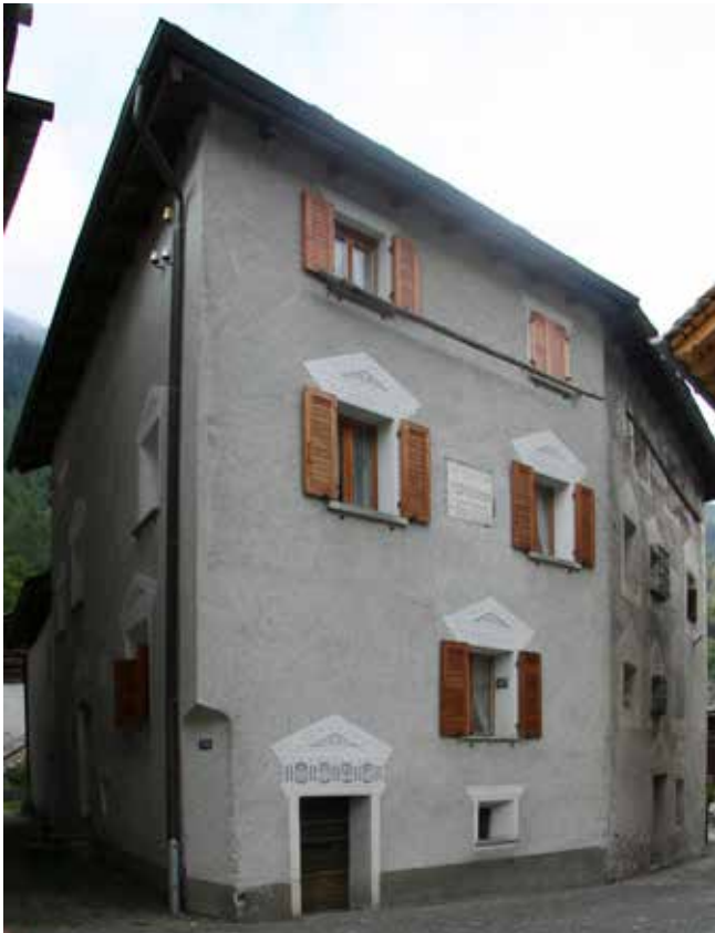
Cäsa Cortini: Doppelhaushälfte Nr. 1-36. Zustand nach Neufassung von 1972.
