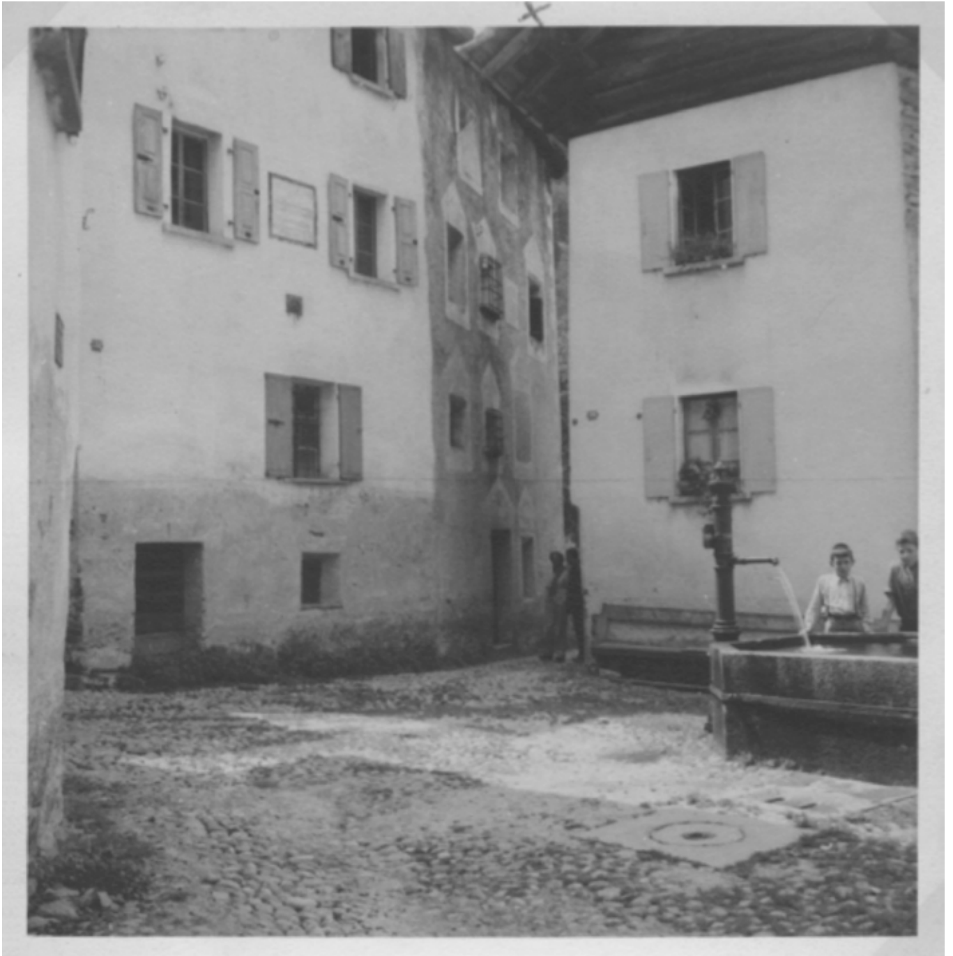
Bondo, Plaza d'Zot: Aufnahme des Gebäudes Nr. 1-36 vor der Renovation 1972. Unter einer späteren Tünche ist die einst vorhandene Sgraffitodekoration noch schwach erkennbar.
