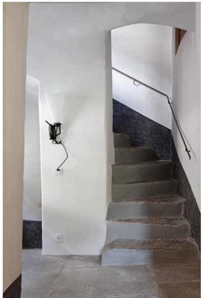
Cäsa Cortini: 1. Obergeschoss, Vorplatz mit Treppe. Aufnahme nach der Renovation.
