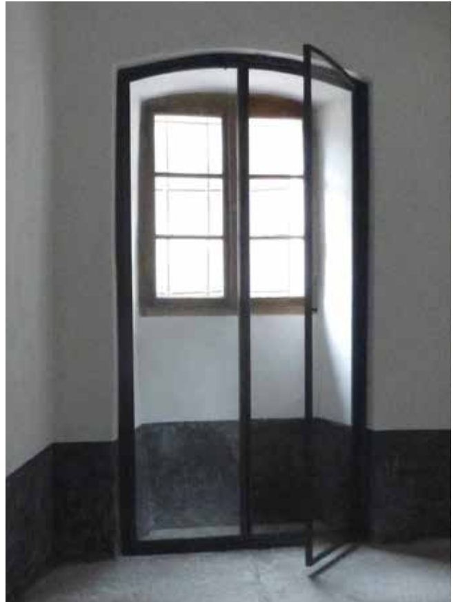
Treppenhaus: neues Holz-Metall-Innenfenster. Aussen das restaurierte Originalfenster.
