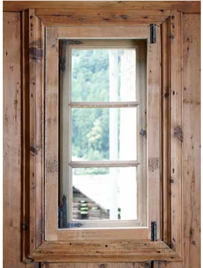
Neues Innenfenster. Aufnahme nach der Renovation
