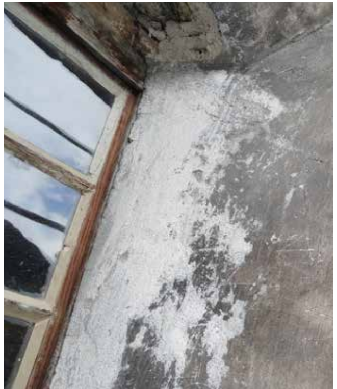
Reinigungsproben in den Fensterleibungen. Aufnahme während der Restauration.
