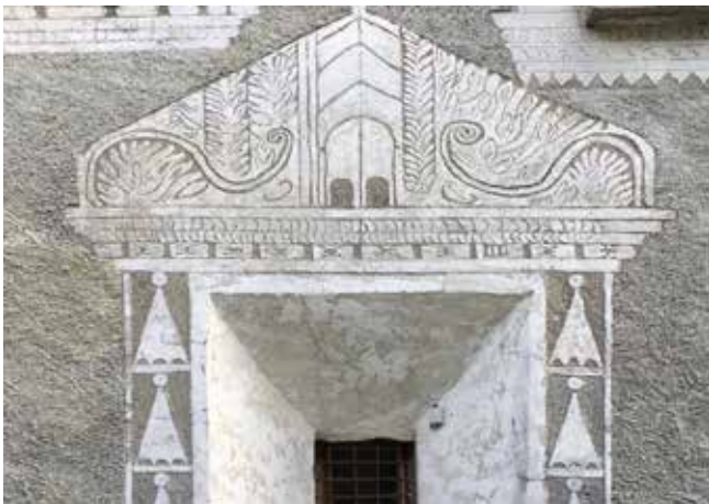
Bondo, Haus Nr. 1-28: Detail Fensterumrandung Keller. Aufnahme 2016.
