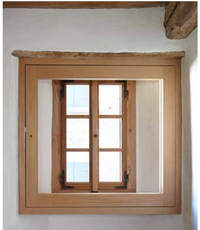
Das Wiederöffnen des zugemauerten Fensters in der ehemaligen Dispensa bedingte aus Brandschutzvorschriften ein Innenfenster EI30. Aussen ein den Originalfenster nachgebautes Fenster.
