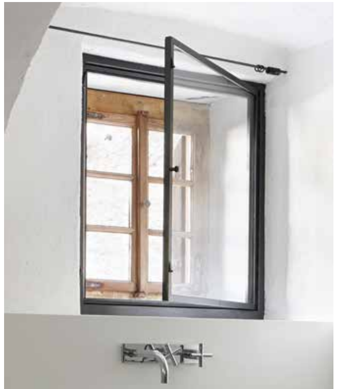
Badezimmer: neues Holz-Metall-Innenfenster. Aussen das restaurierte Originalfenster.
