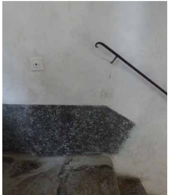
Cäsa Cortini: Kalkputz um 1736 nach dem Ablaugen des Latexanstriches mit restaurierter Sockelmalerei. Aufnahme 2014.
